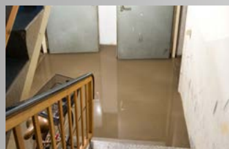
Hochwasser- und Restwasserbeseitigung
