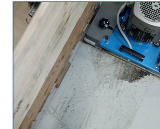
Gründliches Arbeiten an Kanten
